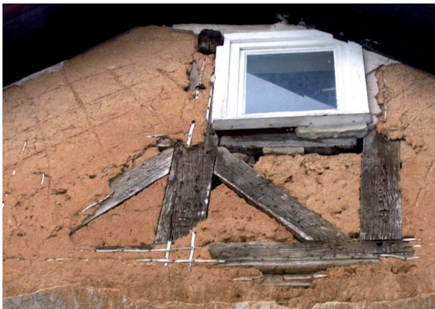
Blick in das Giebelfeld mit teilweise freigelegtem Fachwerk, Saumschwelle mit Band und Inschrift, links oberhalb des Fensters der vortretende Kopf des Stuhlrähms
